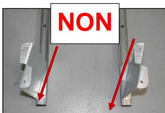
4. Placer **un emplacement de stationnement sur chaque paire de rehausseurs**. Les visser avec vis au-dessus et écrou à embase en-dessous, sans serrer.
